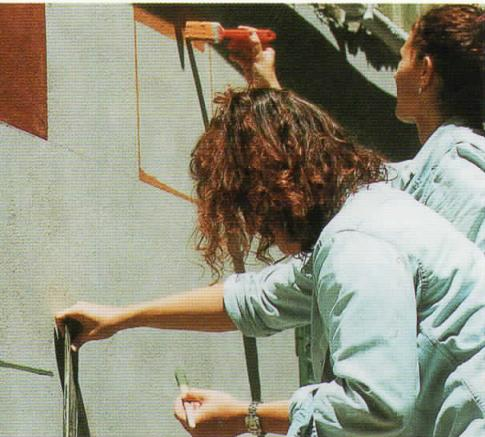
Sull'intonaco fresco del muro di prova, si sono preventivamente tracciate con una punta metallica le linee essenziali della "Tavolozza dei colori", composta da 12 riquadri: 9 colori riguardanti campioni d'intonaco prelevati dai fondi delle facciate, e 3 riferiti a campioni di colori di finestre e persiane desunti da documenti d'archivio. Quindi si è proceduto alla stesura "a fresco" delle tinte nelle singole campiture previste dal "layout" tracciato sul muro.
