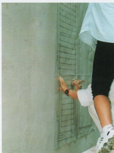
Realizzazione dello spolvero della persiana in trompe-l'oeil mediante strofinamento col tampone sul muro di prova e tracciamento delle linee principali con una punta metallica
