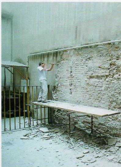
“Muro di prova” del laboratorio del corso, prima della preparazione, durante l’operazione di scrostamento dell’intonaco degradato e di idrolavaggio del muro, dopo lo scrostamento
